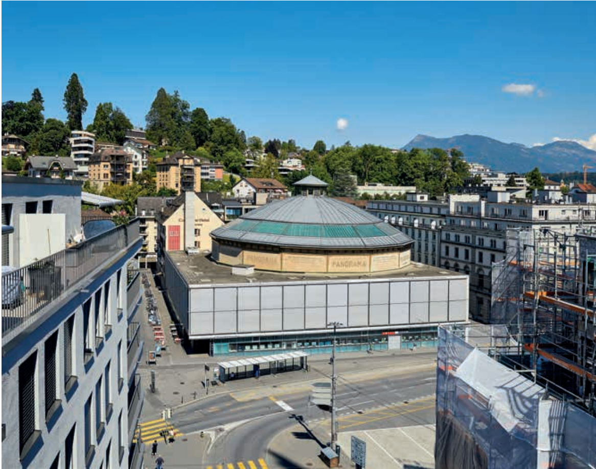
In das Gebäude des Bourbaki-Panoramas in Luzern wurde Mitte der 1920er Jahre eine Garage eingebaut. Noch bis Mitte der 1990er Jahre wurden dort Autos parkiert. Danach wurde die ehemalige Parketage in ein Café umfunktioniert, die Drehscheibe konnte restauriert und funktionsfähig erhalten bleiben. Fotos Dirk Weiss
