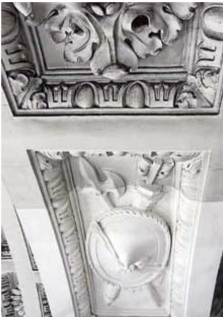
**Kathedrale Solothurn**, Reinigungsmuster: In einem ersten Schritt wurde der lose Staub mit einem Pinsel oder Spezialstaubsauger abgenommen (siehe zweitoberster Streifen), anschliessend die Stuckaturen mit Gummigranulat fein abgestrahlt und dann mit speziellen Reinigungsschwämmen trocken gereinigt...
