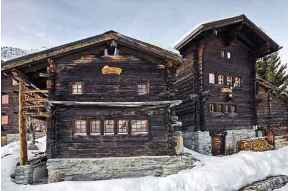
Weiler Weissried: In der heute höchstgelegenen Siedlung des Tales (1700 m) steht das Bletschuhuis (links) mit Dendrodatum 1451 (© GSK, Photo Michael Peuckert).
