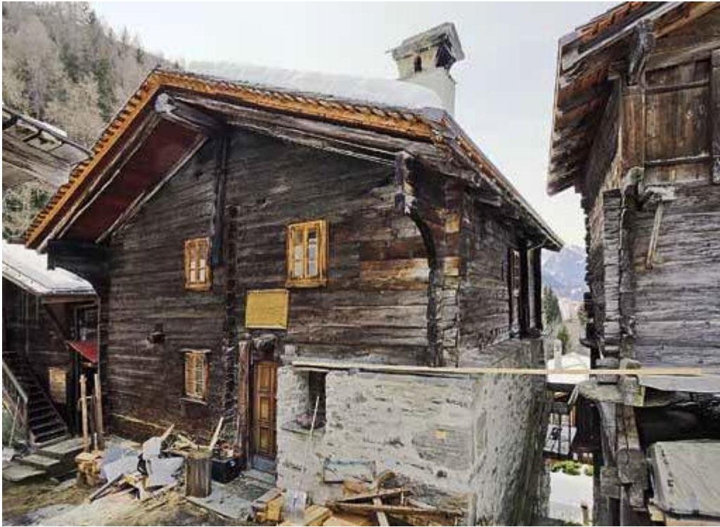
Mühlebach, Goms. Eines von zehn spätmittelalterlichen Wohnhäusern in diesem Dorf, das Schinerhaus (1435), Geburtshaus von Kardinal Mathäus Schiner (* um 1465) (© GSK, Photo Michael Peuckert).
