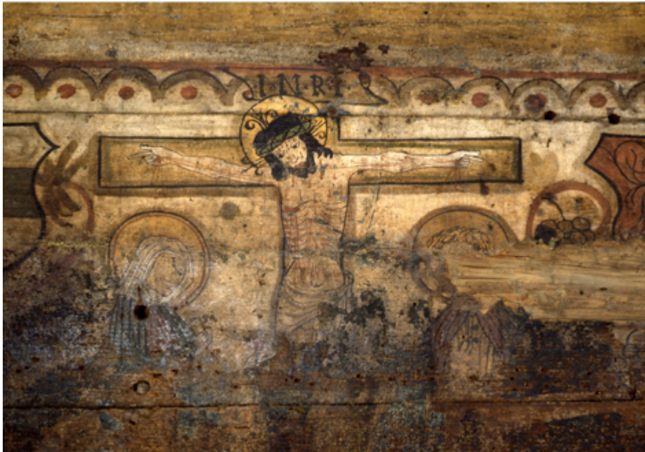
Grabenstrasse 30, Zug, erstes Obergeschoss, Westraum, nördliche Bohlenwand. Kreuzigungsszene mit Maria und Johannes, 1524 datiert (Bildarchiv Kantonale Denkmalpflege Zug).
