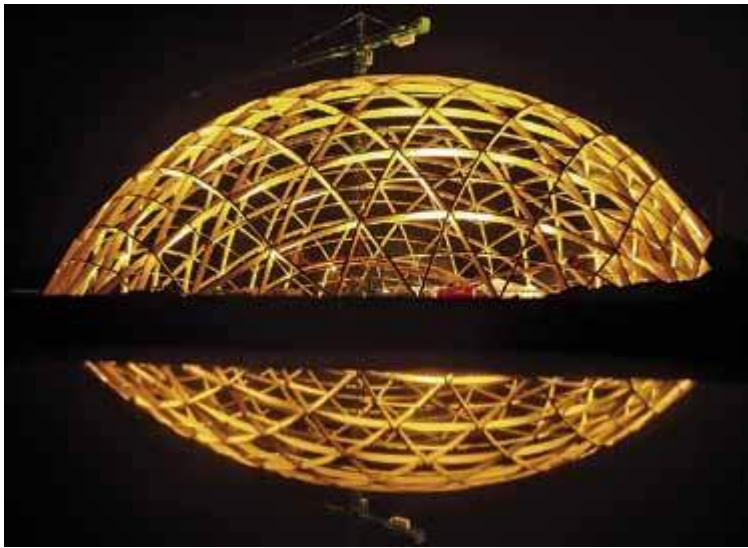
Saldome Rheinfelden: mit einem Durchmesser von 93 m und einer Höhe von 31 m der grösste Kuppelbau der Schweiz - aus Holz (© GSK, Photo Michael Peuckert).
