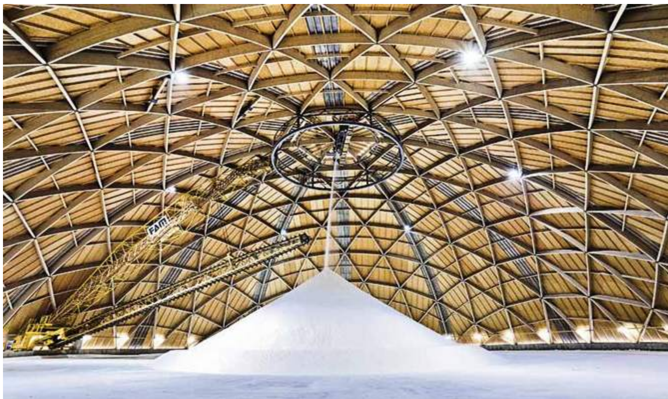
Salzlager des Saldome: das Tragwerk besteht aus drei sich durchdringenden Bogensystemen, die eine Holznetzschale bilden (© GSK, Photo Michael Peuckert).
