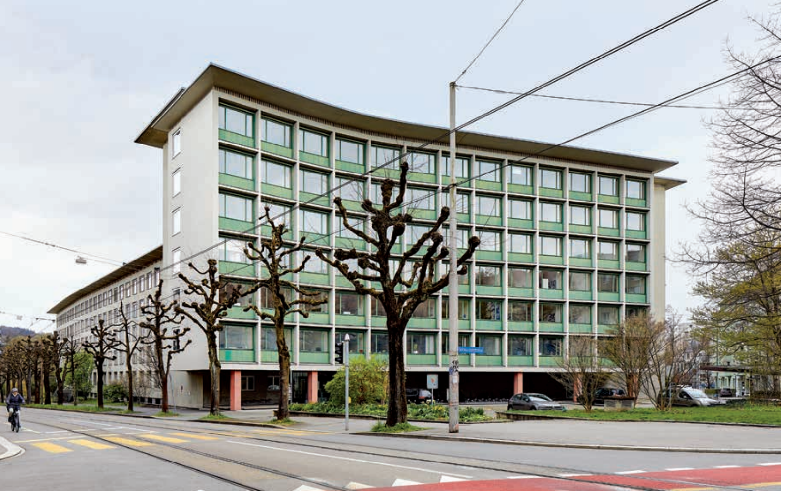
Das 1951–1953 erbaute Verwaltungsgebäude der Eidgenössischen Oberzolldirektion von Gret Reinhard-Müller. Foto Dirk Weiss
