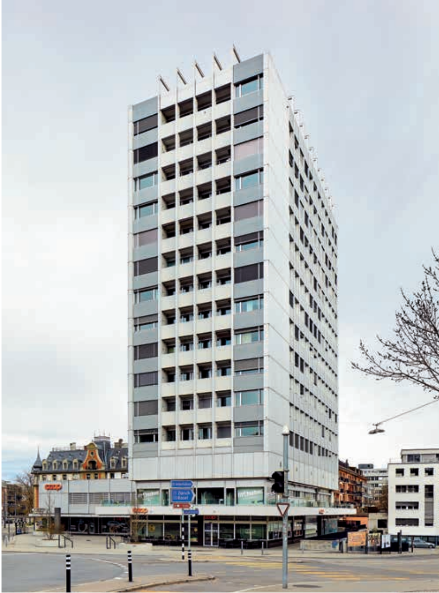
Das 1960 erbaute Büro- und Wohnhochhaus von Claire Rufer am Eigerplatz in Bern. Foto Dirk Weiss
