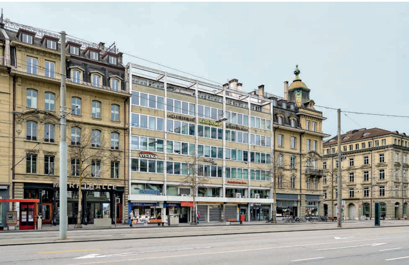
Eine der wichtigen Bauten Claire Rufers im Zentrum von Bern: das Geschäftshaus Gotthard mit Kino aus dem Jahr 1959. Foto Dirk Weiss
