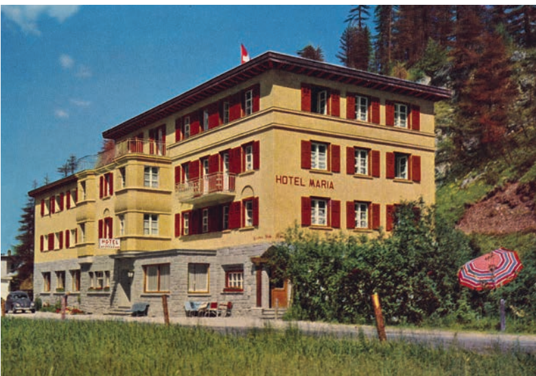
Hôtel Maria , carte postale vers 1960, avec extension du côté gauche du bâtiment, et carte postale vers 1990, après la transformation qui lui a donné sa silhouette actuelle. Photos collection Marcel Just, Zurich
