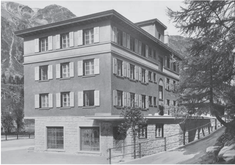
Pension Chesa Cappellari , cartes postales vers 1932-1933. La photo de gauche montre l'arrière du bâtiment
