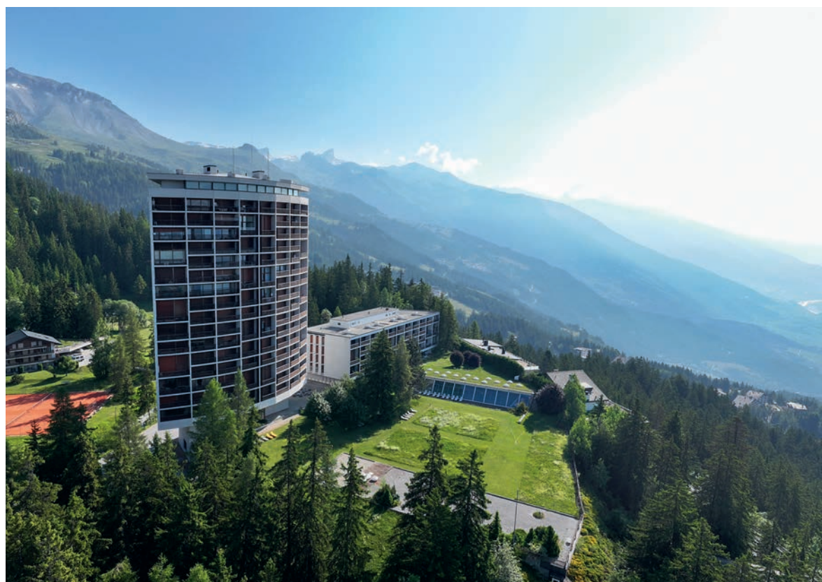
Crans-Montana, tour Supercrans. Vue du sud-ouest. Photo Chab Lathion, 2025
