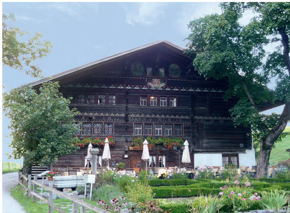
Abb. 9 1753 erbaute Zimmermeister Peter Stoller in Kandersteg BE ein Wohnhaus für Landsvenner Peter Germann. Nach einem Brand 1908 diente es als Schule für Kinder der Bauarbeiter an der Lötschbergbahn, anschliessend als Pension. Daraus wurde der Landgasthof Ruedihus. Foto Gottfried Egger, 2011
