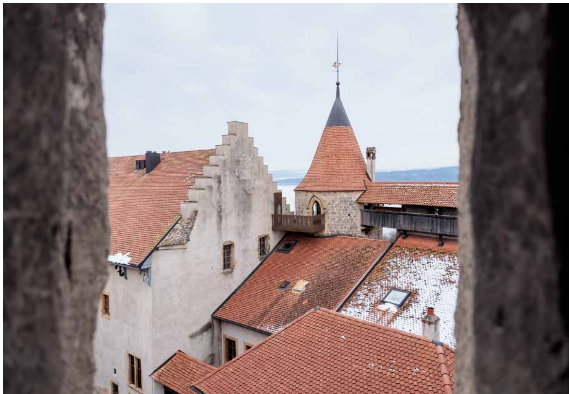
Abb. 4 Blick auf die Dachlandschaft mit dem Belvedere des späten 14. Jahrhunderts und dem im 15. Jahrhundert ausgebauten Wehrgang. Foto Pierre Yves Massot, 2023
