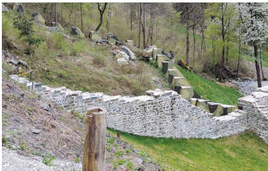
Abb. 7a Geländepanzerhindernis Juvalt GR. Die BBB-Betonblöcke schliessen direkt an die Mauern an und umschliessen die mittelalterliche Strassensperre beidseitig. Foto ADAB-Inventar, Thomas Bitterli
