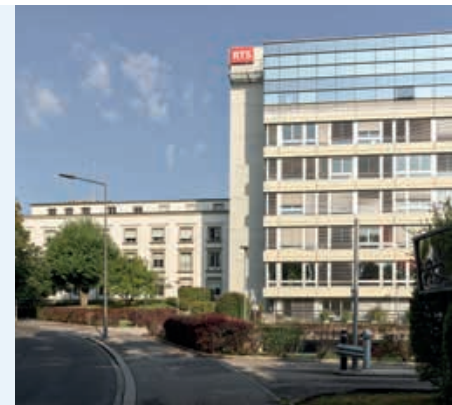
Das mehrfach erweiterte Gebäude der Radio Télévision Suisse in Lausanne, La Sallaz, im Sommer 2025.
