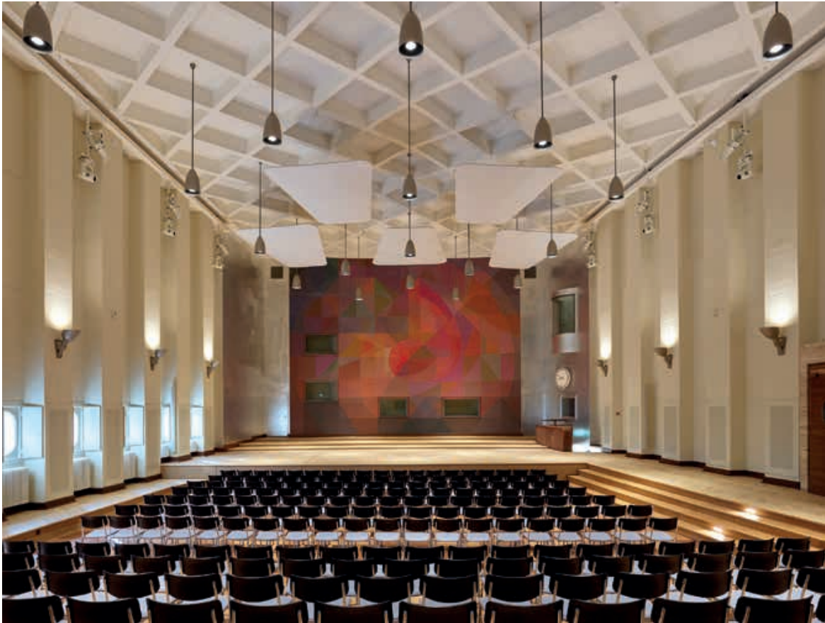
Studio 1 mit dem Monumentalbild von Oscar Lüthy. Der Erhalt der freitragenden Kreuzrostdecke aus Stahlbeton stellte eine Herausforderung dar, da sie aus raumakustischen Gründen mit asbesthaltigem Spritzputz versehen war. Die Tragfähigkeit dieser in der Schweiz erstmals in solcher Dimension erstellten Decke wurde mit Belastungsproben nachgewiesen, 2025. Foto Hannes Henz, Zürich
