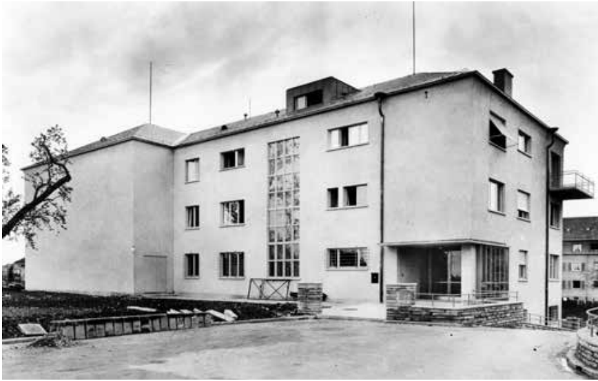
Radiostudio Zürich, 1932/33, Eingangsfrent. Foto BAZ
