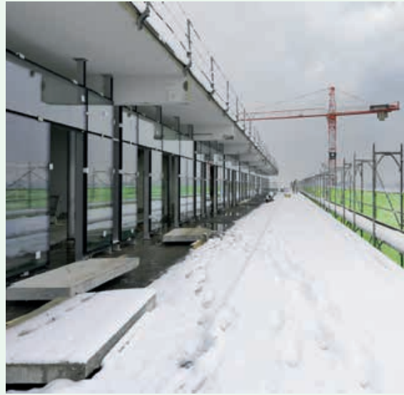
Die über 105 Meter langen Korridore des Spitals (links) werden zukünftig durch Bilder von M. C. Escher in eine Phantasiewelt verwandelt, jedes Geschoss wird eine eigene Identität erhalten. Im Dachgeschoss (rechts) finden sich nach dem Umbau Gemeinschaftsräume. Fotos Veronica Mayer
