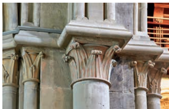
Fig. 11a Chapiteau soutenant la grande arcade de la sixième travée depuis la croisée, pile ouest. Photo Dirk Weiss, 2024
