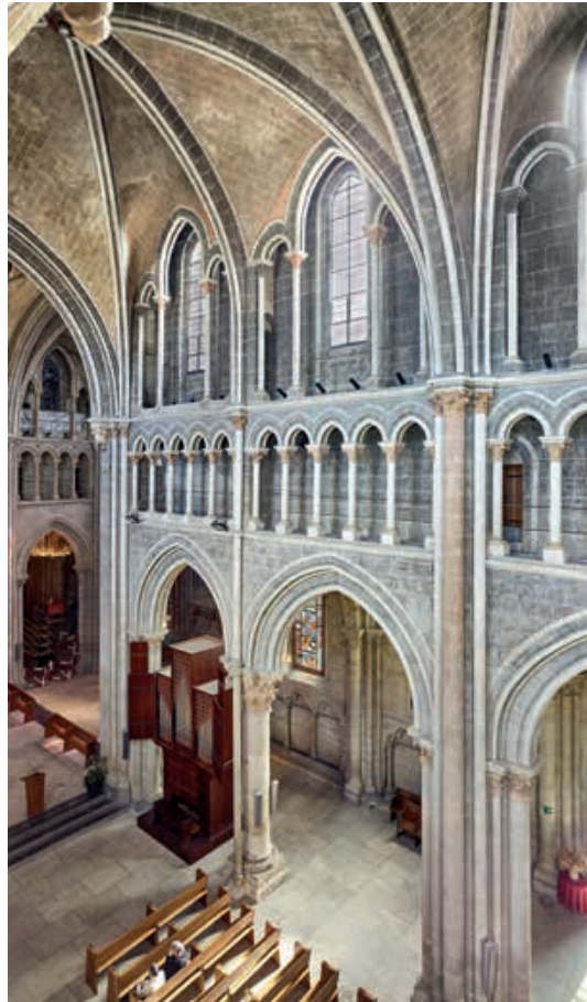
Fig.5 Vue du bras nord du transept, élévation est, travées couvertes par des voûtes quadripartites Photo Dirk Weiss, 2024
