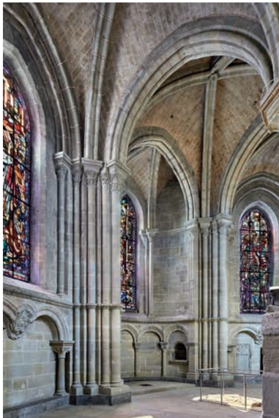
Fig. 4 Vue du déambulatoire et de la chapelle axiale, les piliers composés ont été prévus pour un système de voûtes différent de celui réalisé. Photo Dirk Weiss, 2024
