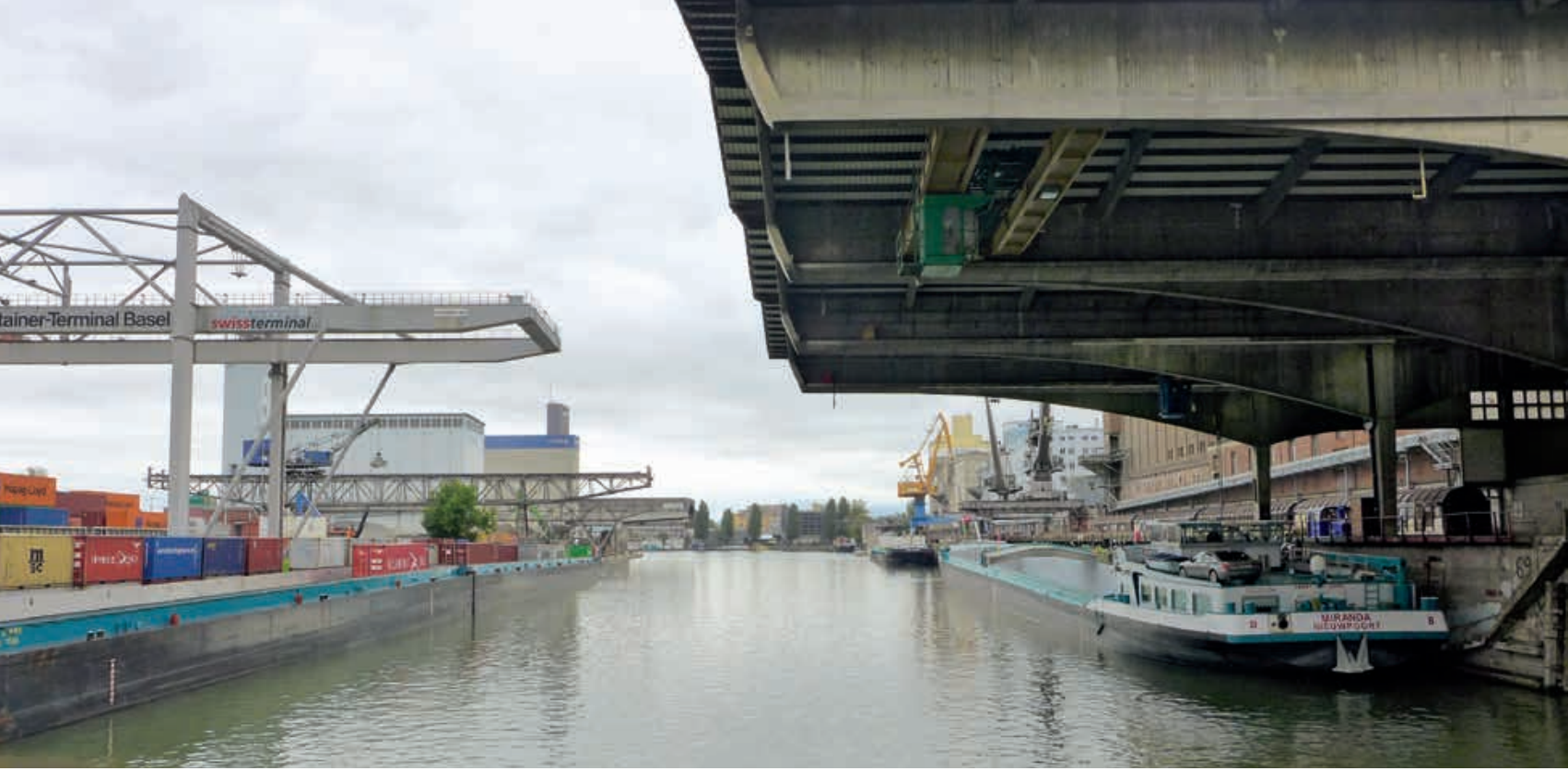
Blick vom Südquai zum Hafenbecken , in das das weit ausladende Dach der Umschlaghalle hineinragt. Foto Viola Müller
