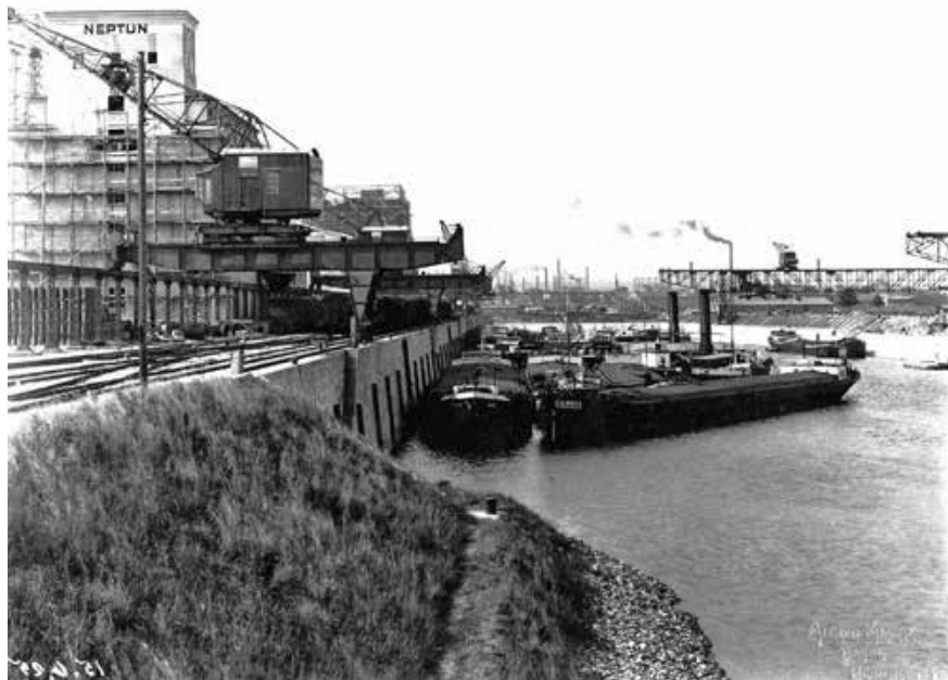
Schiffe am Ostquai 1925. Die Halbportaldrehkrane fahren entlang der Uferkante und auf einer Kranbahn auf Stützen, während dahinter die Silogebäude noch im Bau sind. Foto Archiv Kantonale Denkmalpflege
