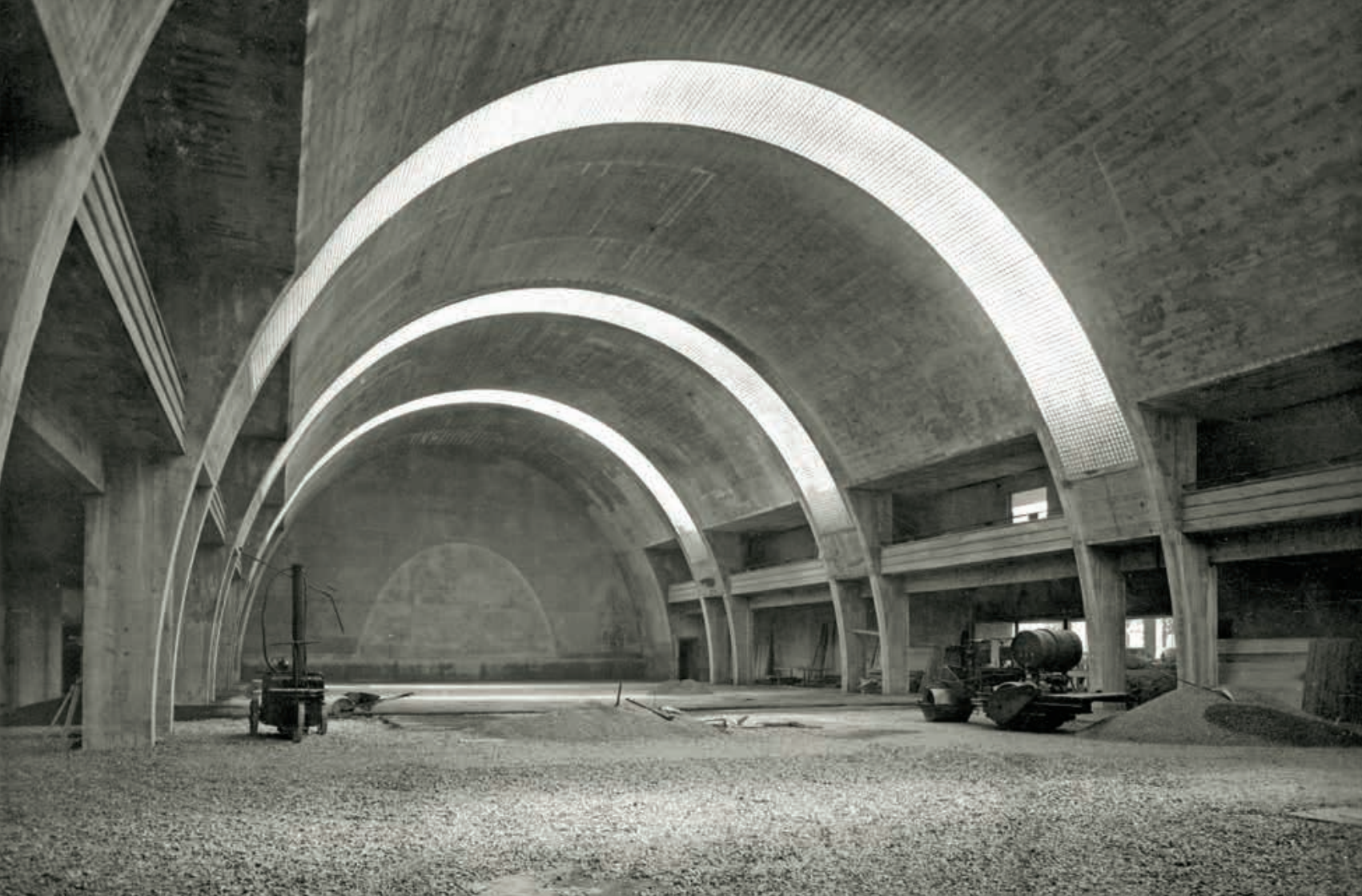
Fig.7 La halle dont la voûte vient d'être décoffrée, vue en direction de l'est, 1935. Photo William Olivier, Musée historique de Vevey
