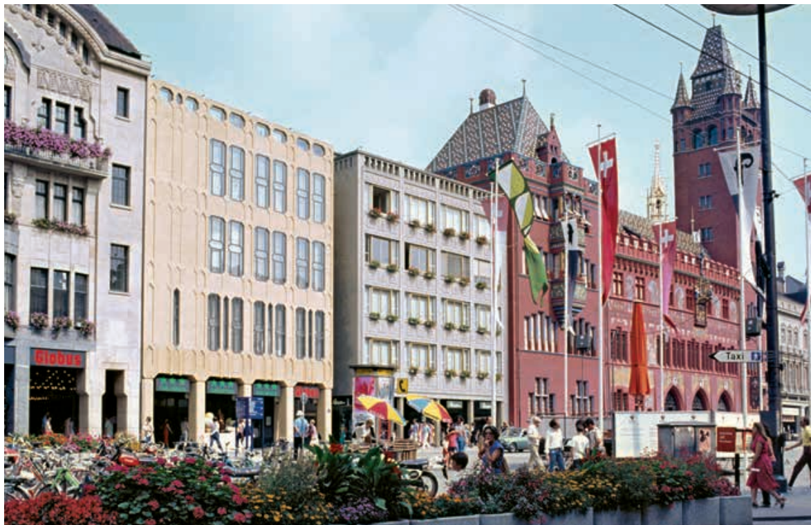
Abb. 14 Basel, Warenhaus Globus: links der Ursprungsbau von 1905 (Romang & Bernoulli), rechts anschliessend der Erweiterungsbau von 1975, Suter+Suter, Mitarbeiter Heinrich Barz (Foto Georg Mörsch, um 1980). ETH-Bibliothek Zürich, Bildarchiv
