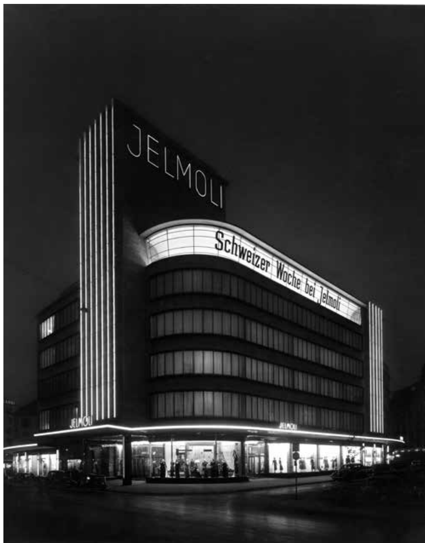
Abb. 9 Zürich, Warenhaus Jelmoli, Erweiterungen von 1931/32 und 1936–38, Arch. Otto Pflughard mit Emil Schaudt und Jean-Paul Mongeaud. Foto Wolf-Bender's Erben, 1938, BAZ
