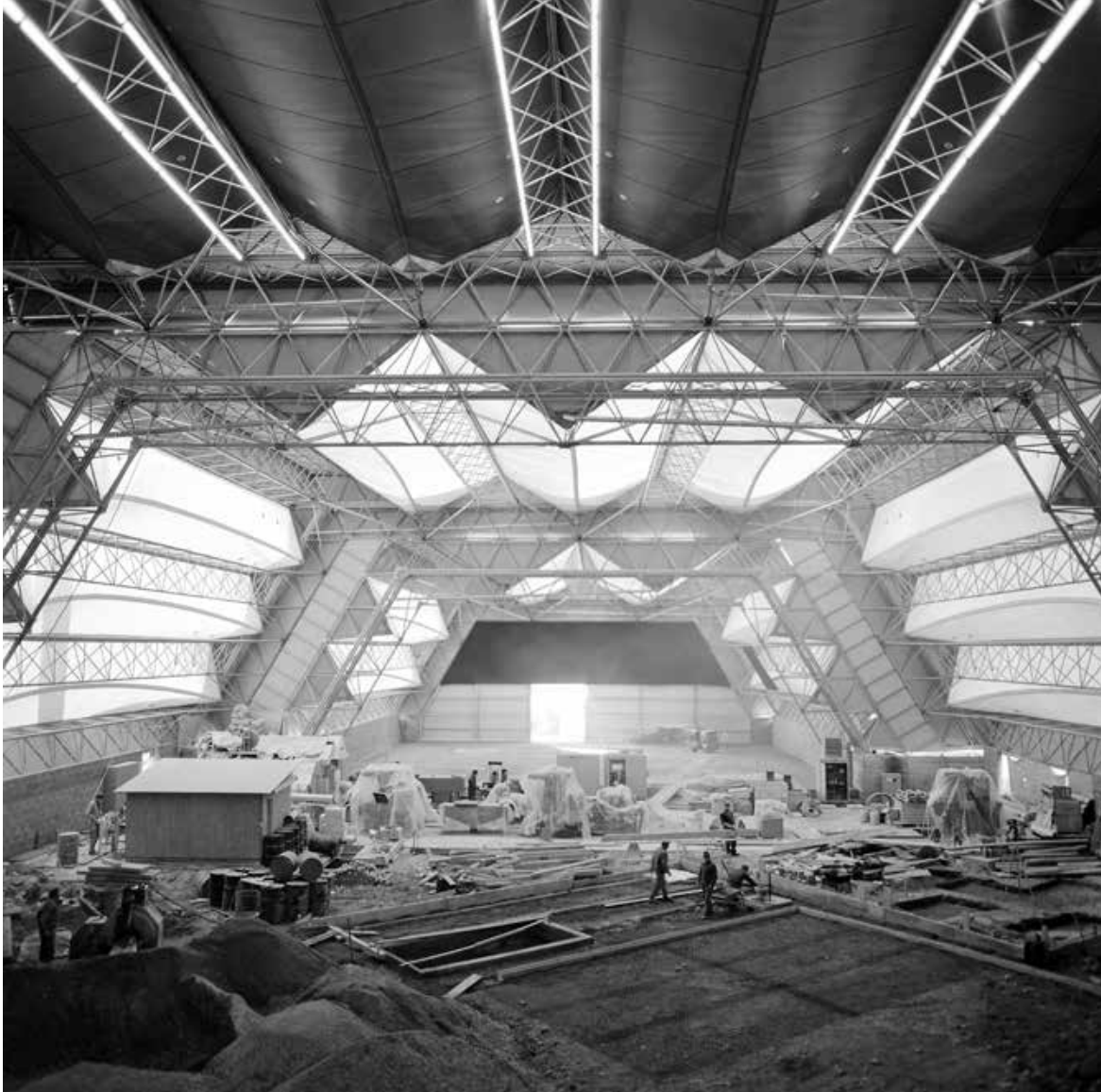
Sektor «Industrie und Gewerbe» im Bau, 6.2.1964. Hier kamen hintereinander geschaltete Dreigurt-Fachwerkträger aus Stahlrohren zum Einsatz, die mit Segeltuchflächen sowie Wandverkleidungen aus Kunststoffplanen versehen wurden (Bildarchiv ETH-Bibliothek Zürich)
