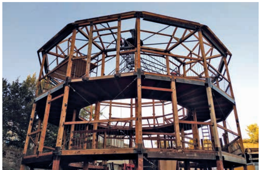
La Tour Vagabonde, construite en 1996 par le collectif fribourgeois des Ateliers de l'Orme, représente cinquante tonnes de matériel (bois, métal, bâche). Photo Aruna Canevascini
