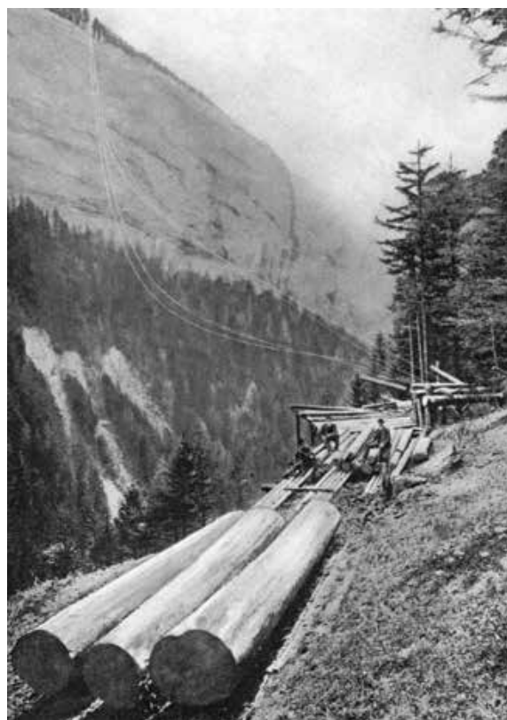
Mit der Seilbahn für den Holztransport in der Viamala erlangte die Firma Coray und Telli grosse Anerkennung. Coray entwickelte hier zum ersten Mal eine «richtige» Transportseilbahn mit zwei Tragseilen und einem Zugseil. Beeindruckend ist die Linienführung über den grossen Felsen unterhalb des Maiensässes Breitenberg (Fotograf unbekannt / Aus Gustav Bener. Gerüst- und Seilriesenbauer Richard Coray von Trins (Graubünden) zu seinem erfüllten siebenzigsten Jahr, 30. Juli 1939. Chur 1939, Tafel 1)
