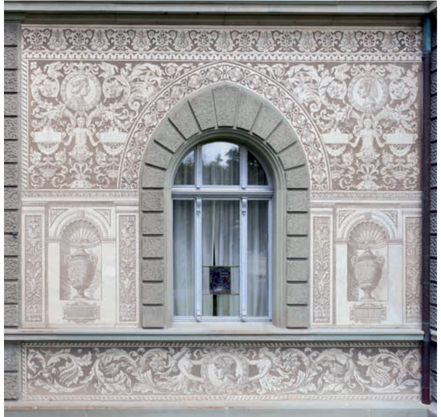
Abb.8 In einer Zone unter dem ersten Obergeschoss befinden sich an allen drei Sgraffito-Fassaden Akanthusranken, denen Frauenoberkörper entwachsen. Sie halten von Lorbeerkränzen und Bändern umgebene Porträts. © Kantonale Denkmalpflege Aargau, Foto Roger Wehrli, 2023
