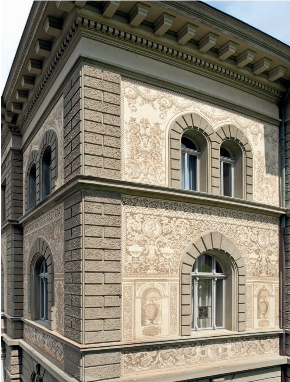
Abb. 7 Die reich dekorierte Südfassade zeigt die spannungsvollen Gegensätze von hellen und dunklen Sgraffiti bzw. Hintergründen. Die Akzentuierung der Fassadenelemente mit ornamentalen Friesen und Girlanden kommt dabei deutlich zum Ausdruck. © Museum Zofingen, Foto Roger Wehrli, 2023
