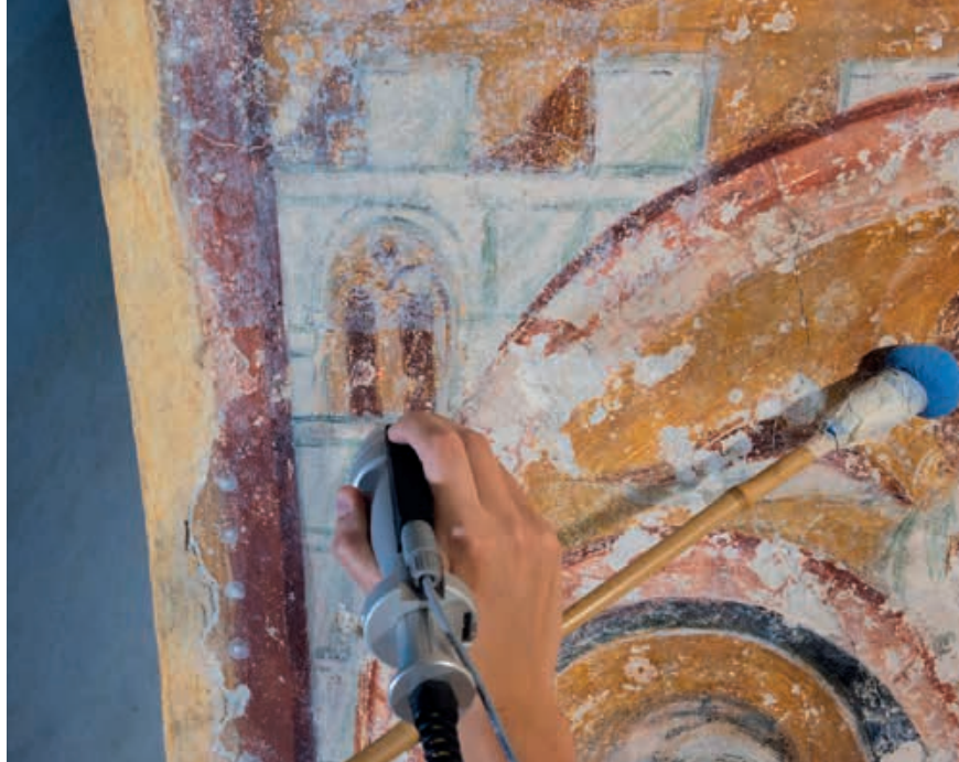
Fig.11 Part. del sottarco, durante la fase di pulitura con strumentazione laser per la rimozione dei residui di scialbo. Foto Paola Iazurlo
