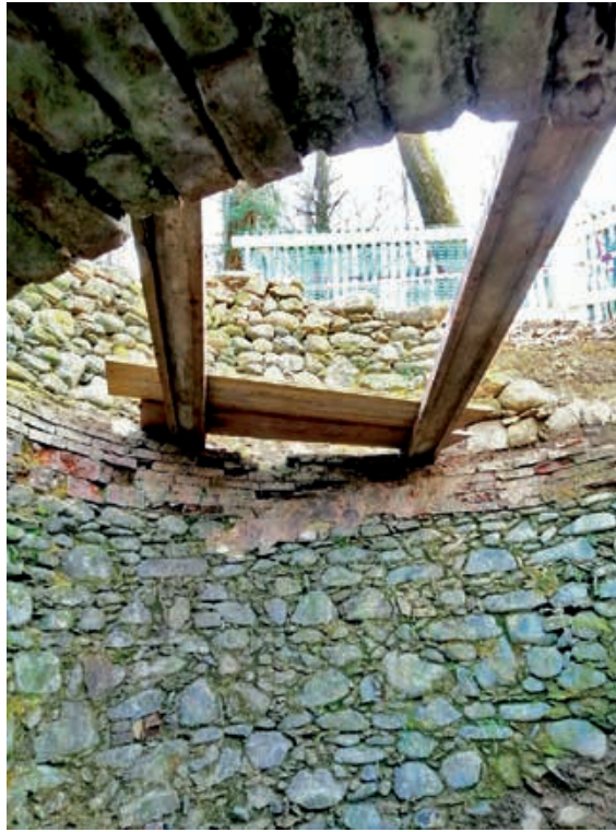
Fig. 4 Veduta dall'alto durante lo sgombero dell'interno: si riconoscono il restringimento del vano inferiore, intonacato con malta di cemento, una delle travi di metallo su cui poggiava il pavimento e l'intonaco a calce della camera superiore. © Flavio Zappa
