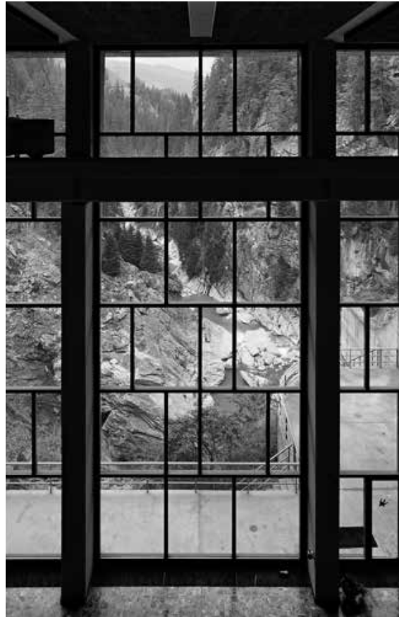
Die Zentrale Ova Spin der Engadiner Kraftwerke AG (1970). Das enge Tal und die Unmöglichkeit, im Nationalpark grosse und frei stehende Bauten zu errichten, hatten zur Folge, dass Stausee, Zentralengebäude, Seeüberlauf und die gewaltigen Fundamente zu einem einzigen Gebäude verschmolzen wurden. Foto Christian Kerez
