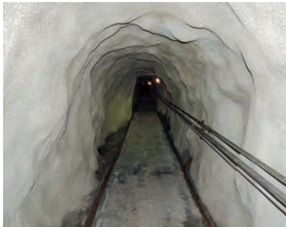
Mit Spritzbeton (Gunit) ausgekleideter Zugangstollen im Infanteriewerk Toveyres, Lavey-Morcles VD. Foto ADAB-Inventar, Thomas Bitterli
