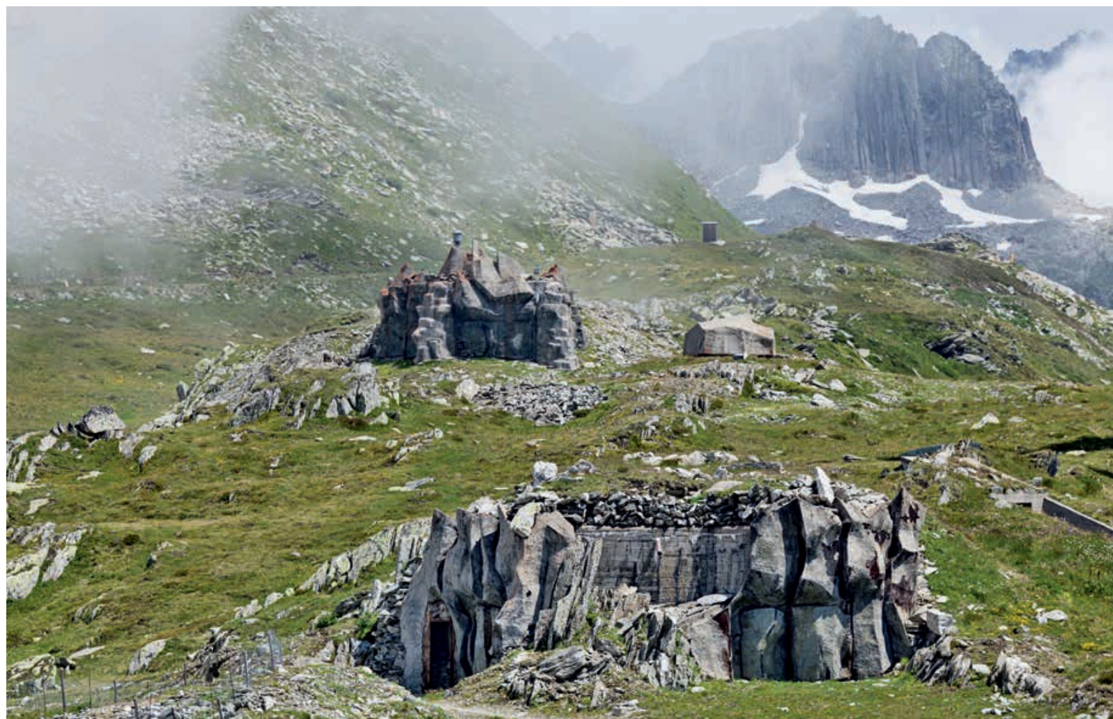
Das Artilleriewerk Gütsch bei Andermatt UR war im Zweiten Weltkrieg die höchstgelegene Festung Europas auf 2300 m ü. M. Für die wintersichere Erschliessung wurde 1941 die Luftseilbahn von Göschenen gebaut; deren Bergstation hat einen direkten unterirdischen Zugang zum Werk. Heute befindet sich auf dem Gütsch eine der wichtigen hochalpinen Wetterstationen. Foto Michael Peuckert
