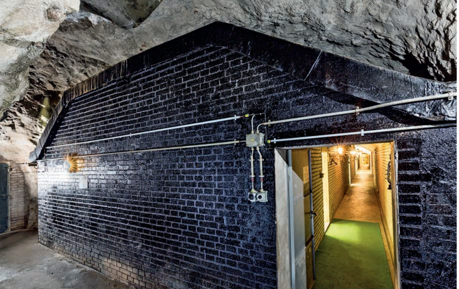
Die Backsteinwände des Kommandopostens der Gebirgsbrigade 9 in Selgis sind mit Flüssig-asphalt überzogen. Foto Michael Peuckert
