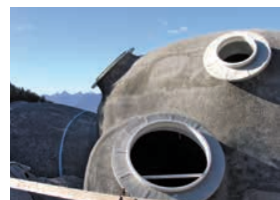
Im Schnitt ist deutlich erkennbar, wie sich das Amden-Haus sanft ins Gelände einfügt (links oben). Vor der Erdüberdeckung: der Rohbau mit der Schalen-Spritzbeton-Konstruktion, die anschliessend mit Polyurethanschaum isoliert wird (Bilder rechts). © Atelier Werner Schmidt GmbH
