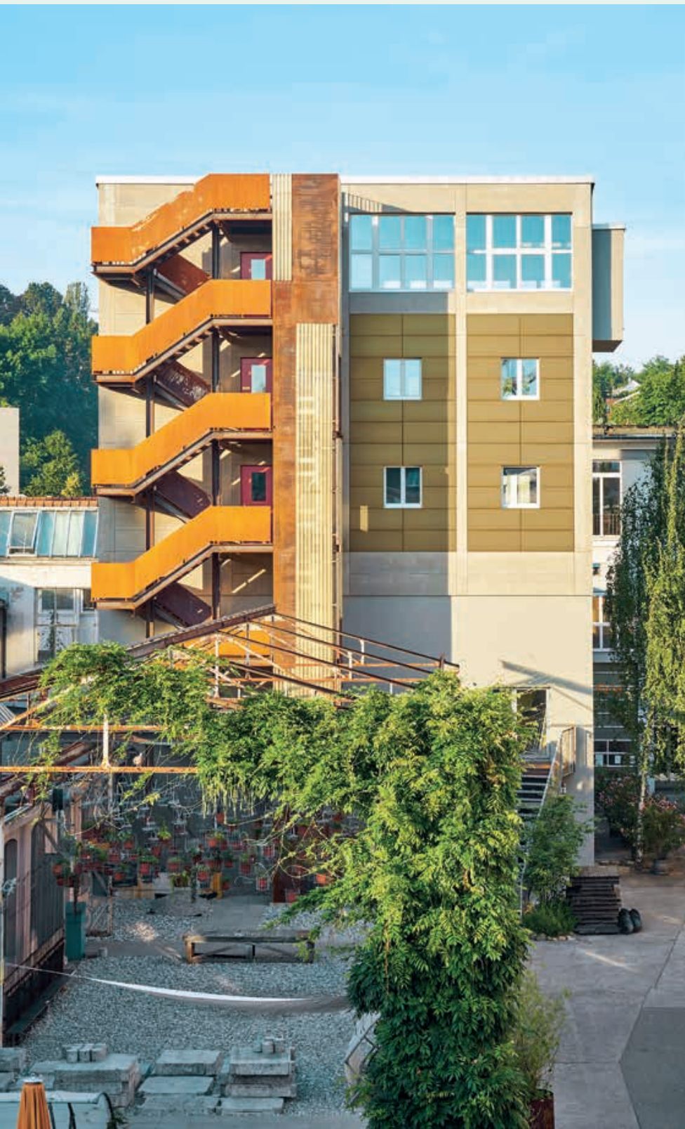
Die Arealentwicklungen auf dem Gundeldingerfeld (diese Seite und S. 39, oben) und auf dem Walzwerk in Münchenstein (S. 39, unten) sowie die Transformation des ELYS-Gewerbehaves (S. 39, Mitte) gehören zu den wegweisenden Projekten des Baubüros in situ. Fotos Martin Zeller, © baubüro in situ AG
