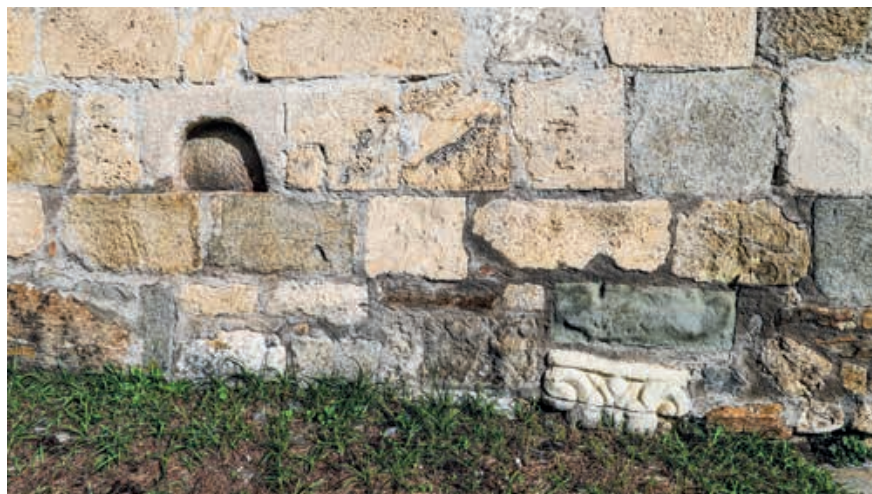
Fig. 9 Porzione del fianco meridionale con un archetto e un capitello di reimpiego. Quinto, chiesa dei Santi Pietro e Paolo (foto Ernesto Palmieri)
