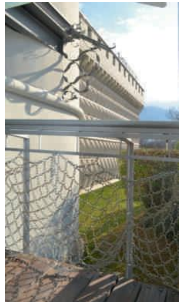
Particolare del parapetto ingresso principale lato ovest. Foto Maria Piceni (2020)
