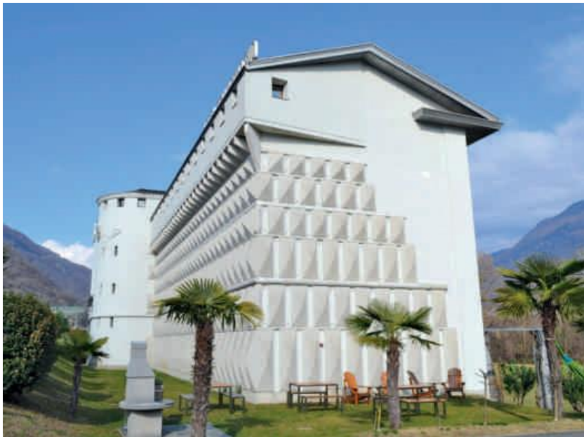
Albergo Mövenpick, Bellinzona (1990), progettato da Bruno Reichlin e Fabio Reinhart, ora Hotel Bellinzona Sud. Prospetto ovest e sud con le bugne agganciate al muro con supporti metallici. Foto Maria Piceni (2020)
