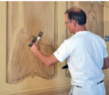
Holzimitationsmalerei eines Tafelparkettbodens in Nussbaum auf Betonboden, Grundlasurauftrag (links oben) und fertig ausgemalt (Mitte oben). Haus zum Rechberg, Zürich: Aufmalen des Nussbaum-Maserbildes in den Füllungen, ausgeführt mit Bierlasur und Zackenpinseln (links unten). Rechts oben: Mehrschichtiger Aufbau mit zwei Grundanstrichen (1/2); erstem Lasurauftrag und Holzmaser mit Bierlasur (3); Auftragen der Poren mit Porenwalze (4); erster Öllasurauftrag sowie Einarbeiten und Verwischen von Maser und Wimmern (5); zweiter Öllasurauftrag zur farblichen Angleichung z.B. an den Boden (7). Rechts unten: Detailaufnahme der Imitationsmalerei in Nussbaum. Fotos Marius Fontana
