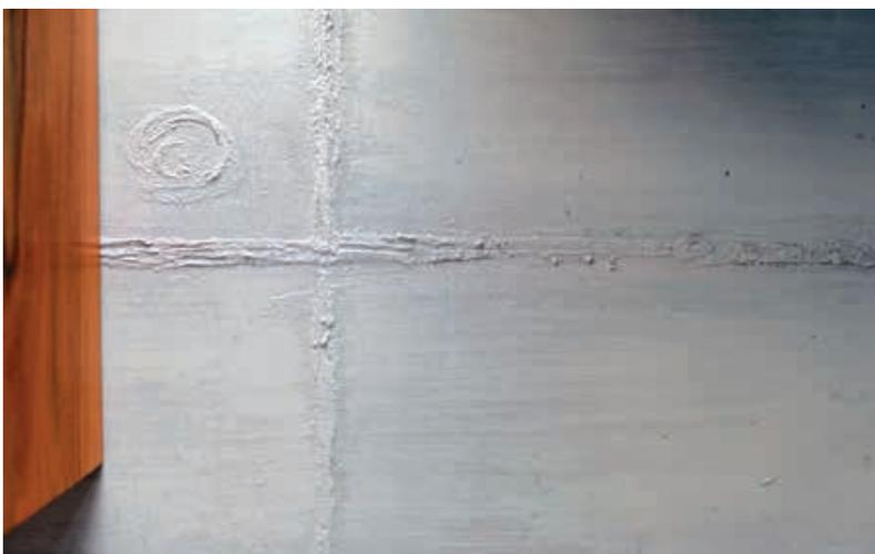
nerseits unschöne Betonoberflächen oder Flickstellen farblich in den Bestand integriert werden, andererseits besteht auch die Möglichkeit, einer sanierten Betonfläche oder Fassade weitgehend das ursprüngliche betonsichtige Erscheinungsbild zurückzugeben. Zudem können damit materialtechnisch andere Flächen ausgezeichnet oder in einen vorhandenen Betonbestand integriert werden.
