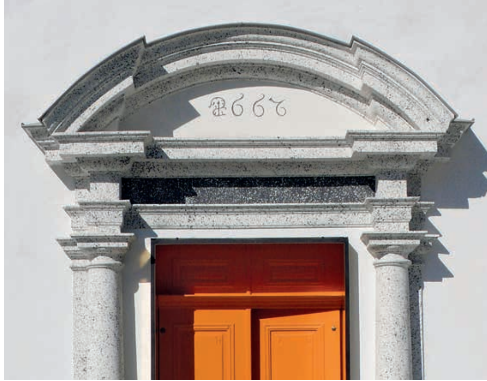
Kirche San Giachem in Bever GR. Die Steinsprenkel wurden mit Bürsten und mit unterschiedlichen und selbsthergestellten «Rutenbesen» von Hand mit Mineralfarbe auf den Untergrund aufgespritzt (links). Das Eingangsportal mit heller und dunkler Steinimitationsmalerei, Schlusszustand (rechts). Verwendetes Werkzeug, Bürsten und selbst angefertigte «Rutenbesen» zum Aufspritzen der Farbsprenkel auf die Putzoberflächen. Fotos Marius Fontana
