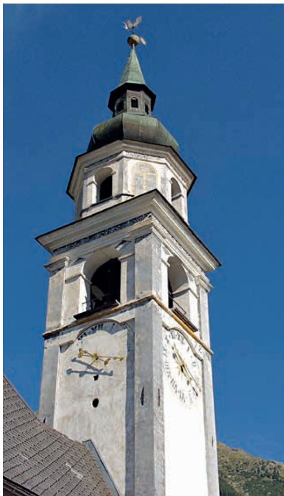
Kirche San Giachem in Bever GR. Rekonstruktion der barocken Steinimitationsmalerei auf den verputzten Fassadenflächen. Zustand vor (links) und nach der Restaurierung (rechts). Fotos Marius Fontana
