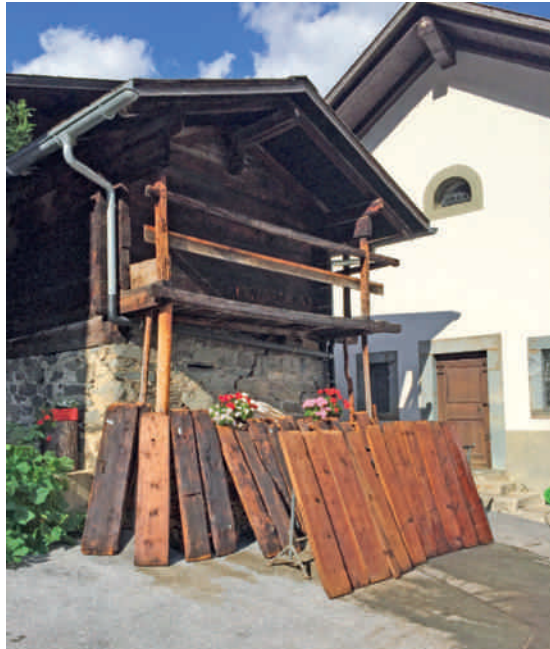
Ausgebauter Schieb- boden nach dem Waschen auf dem Dorfplatz. Foto David Vaner
