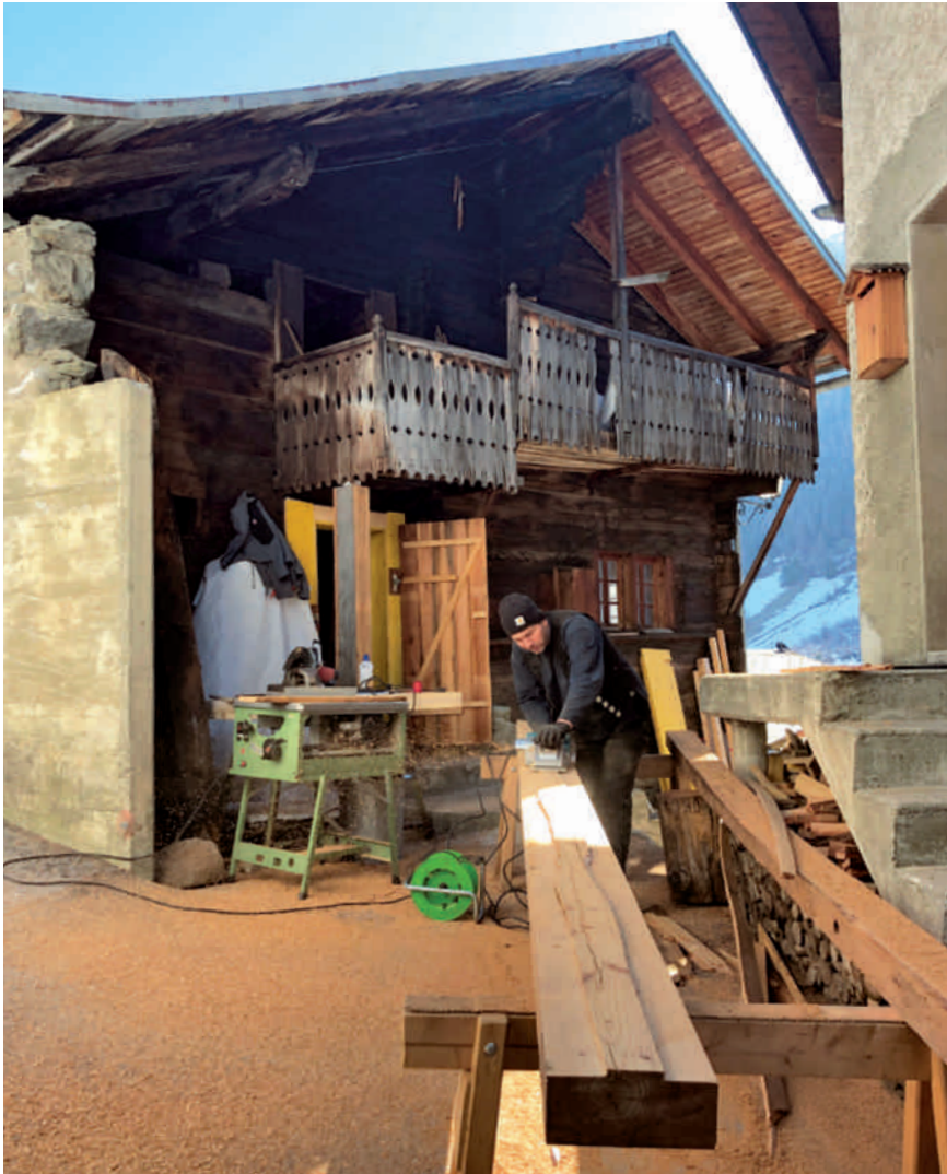
Das «Anselmhuis» von 1556 mitten im engen Dorfgefüge von Ferden VS. Seine Sanierung verdeutlicht den Wert des Handwerks und den zeitgemässen Umgang mit traditionellen Konstruktionen im Alpenraum. Foto Sara Ellenberger Vaner
