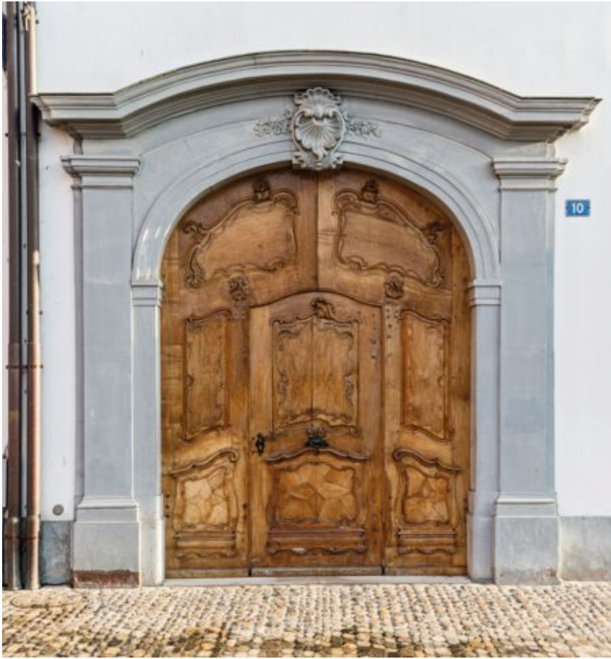
Eingangstor des Regisheimerhofs, Münsterplatz 10. Von Jakob Ramsperger, 1780er Jahre. Foto Michael Peuckert
