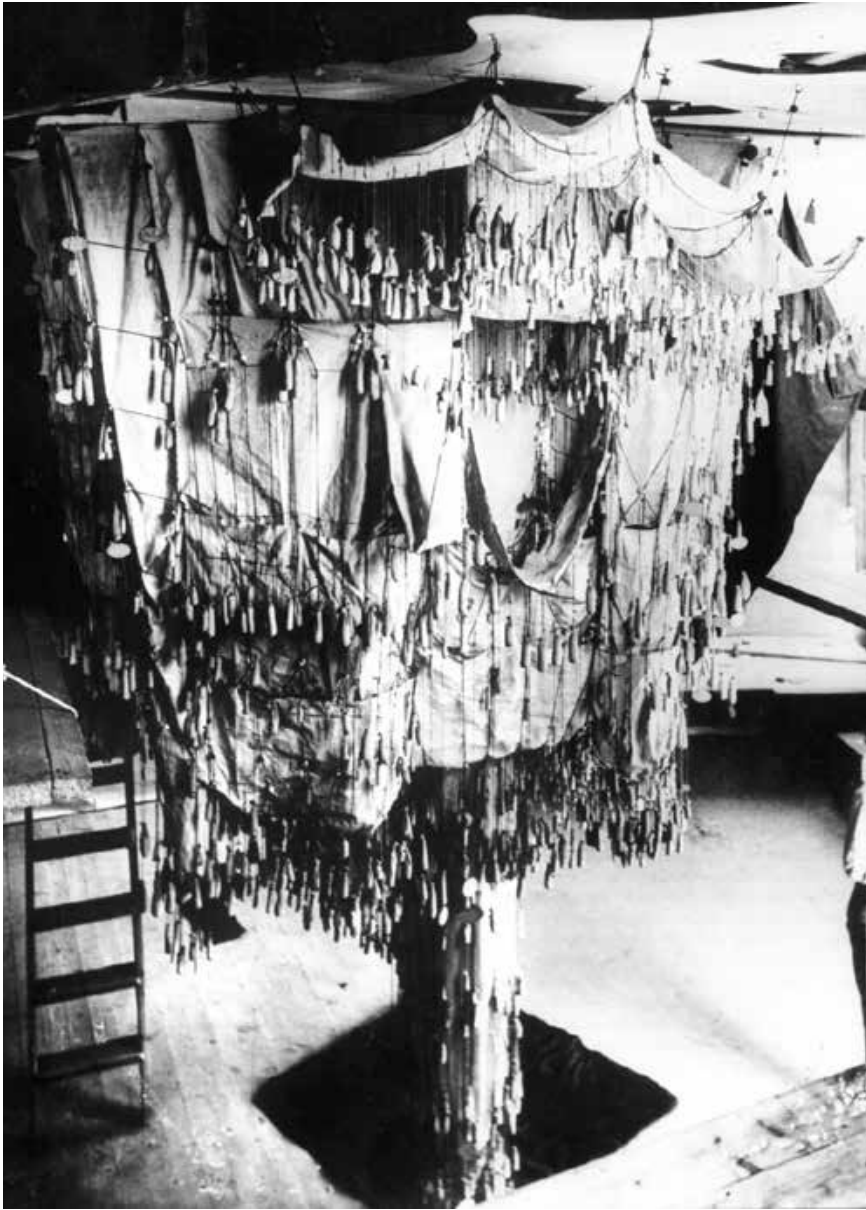
Abb. 2 Antoni Gaudí, Hängemodell, das zur Formfindung der Kirche der Colònia Güell gebaut wurde, ca. 1900. Foto z.V.g.
