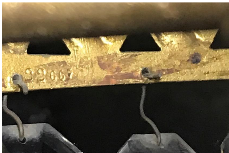
Abb. 15: Fabrikationsnummer an der Innenseite des gegossenen Reifens des Lustre Mongonlière (Foto: Benno Schubiger)
