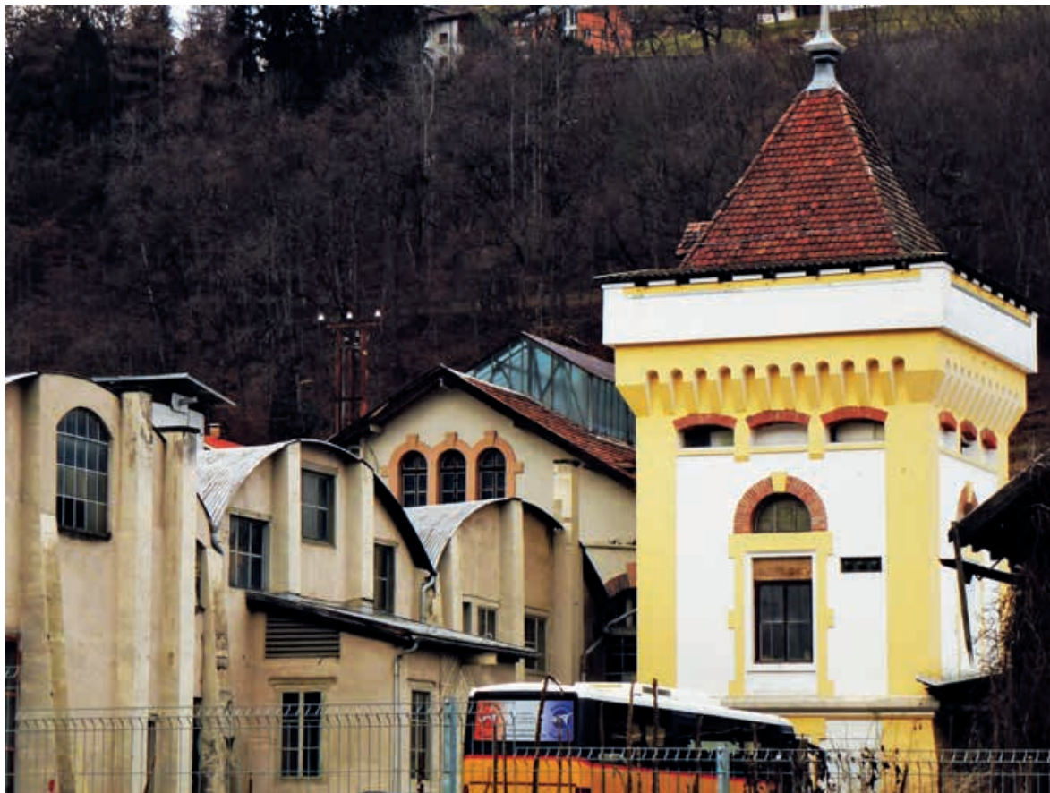
Abb. 6 Auf dem Gelände der ehemaligen Karbidfabrik von Thusis steht dieser sehr alte Trafo von 1899. Sein Schlösschenstil findet das Vorbild auf dem Areal der Gasfabrik Schlieren. Foto Yvonne Scheiwiller, 2012
