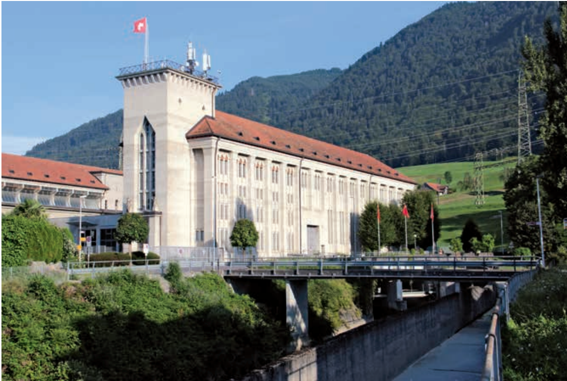
Abb. 11 Kraftwerk Wägital, 1922–1925, Maschinenhaus Siebnen, Arch. Adolf und Heinrich Bräm (Foto Melchior Fischli, 2024)
