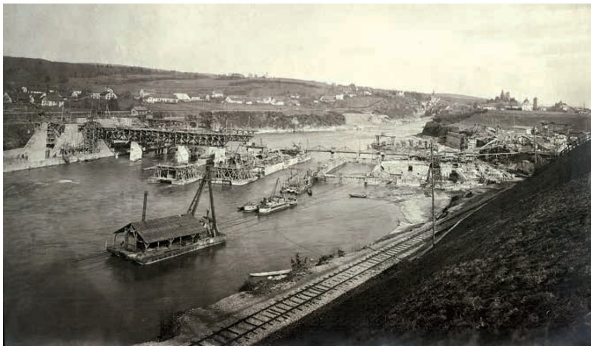
Abb.3 Kraftwerk Laufenburg, die Baustelle um 1909 (Museum Schiff, Laufenburg)
